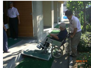
写真 23 非常出口の段差
