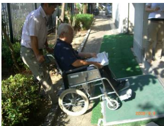
写真 21 非常出口の段差
