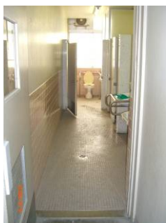
写真 30 障害者用女子トイレ
